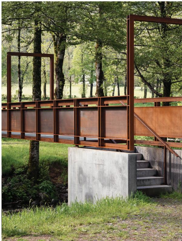
Le choix de matériaux très pérenne, raconte le rude climat des Monts du Cantal. Les piles en béton ancrées dans le sol fabriquent un piédestal sur lequel a été déposé la passerelle en acier autopatinable pensée comme une poutre. L'ensemble de sa structure évoque le langage des tôles ondulées rouillées qui ont remplacé le chaume des granges-étables depuis la moitié du 20<sup>e</sup> siècle. Mais cette teinte est aussi celle des fougères et des hêtres qui font vibrer les coteaux à l'automne.
