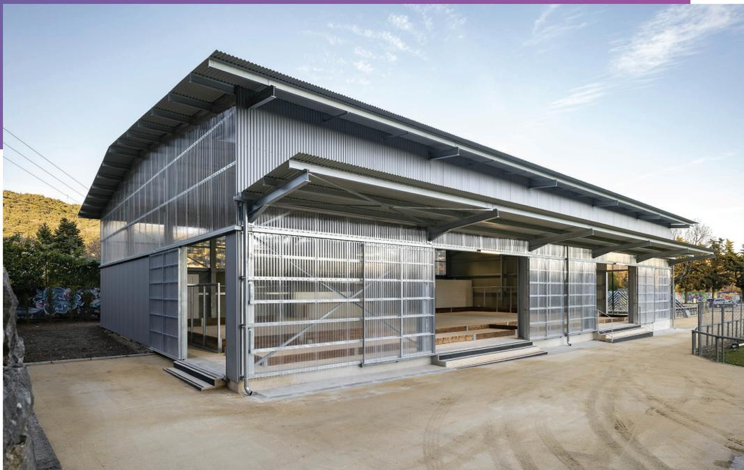
Les matériaux et couleurs utilisés appartiennent à l'univers du hangar car ils restent la meilleure adéquation entre le savoir-faire, l'économie et la robustesse demandés : charpente métallique galvanisée, bardage et toiture en tôle ondulée thermolaquée et polycarbonate ondulé, parpaings brut peints, bois massif, sol en béton brut.
