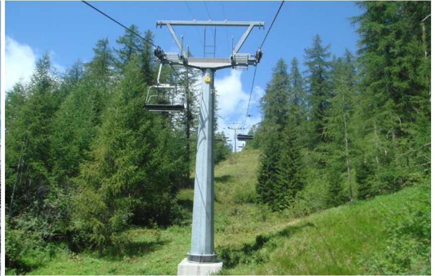
Pylônes de remonte pente
