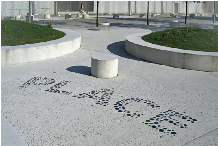
Des inscriptions en inox, insérées dans la surface en béton gris mat de la place, scintillent à la lumière tels des cristaux.
