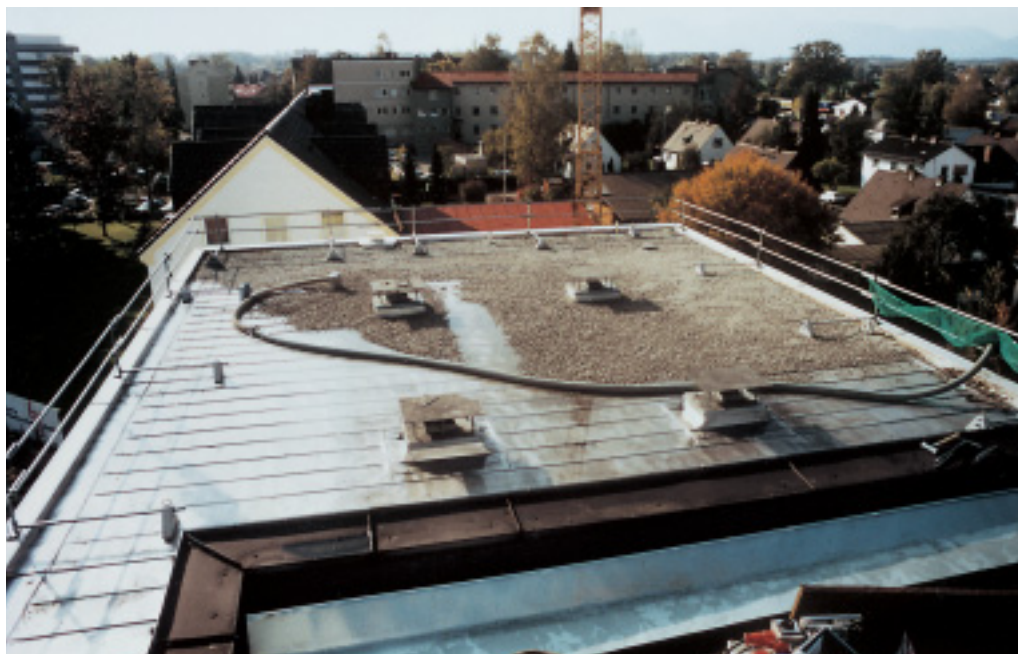
Une couche de gravier est amenée sur le toit par pompage.
