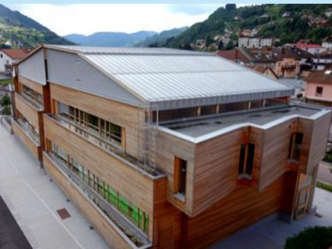
L'épaisseur typique d'une tôle de toiture est de 0,4 ou 0,5 mm. En façade comme en couverture, la nuance doit être adaptée à l'état de surface. A noter que l'absence de relargage permet la récupération des eaux pluviales.
