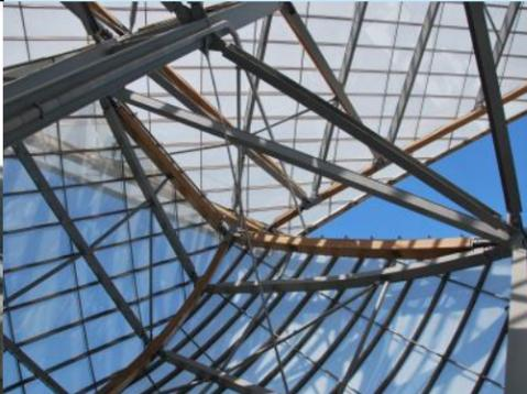
L'acier inoxydable austénitique est un choix courant pour les façades vitrées et autres structures secondaires. Les nuances duplex (austéno-ferritiques) sont aussi utilisées pour des structures lourdes telles que les passerelles en milieu côtier. L'acier inoxydable est incombustible et ne dégage pas de fumées toxiques. En termes de réaction au feu, il est classé A2s1d0. Il a aussi une excellente résistance au feu avec une température de fluage élevée et supérieure à 800 ° C.
