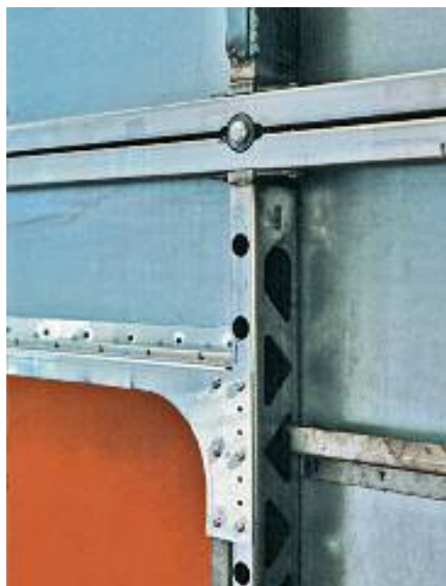
Figure 23 : Sur cette paroi d'un train de banlieue, la structure et les panneaux extérieurs sont faits de nuances différentes d'inox. Comme ceux-ci ont des potentiels identiques, il ne peut y avoir de corrosion galvanique.
