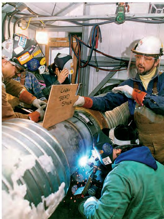
**Soudage mécanisé d'un oléoduc de grand diamètre en acier duplex (Source : Arco Exploration and Production Technology)**
