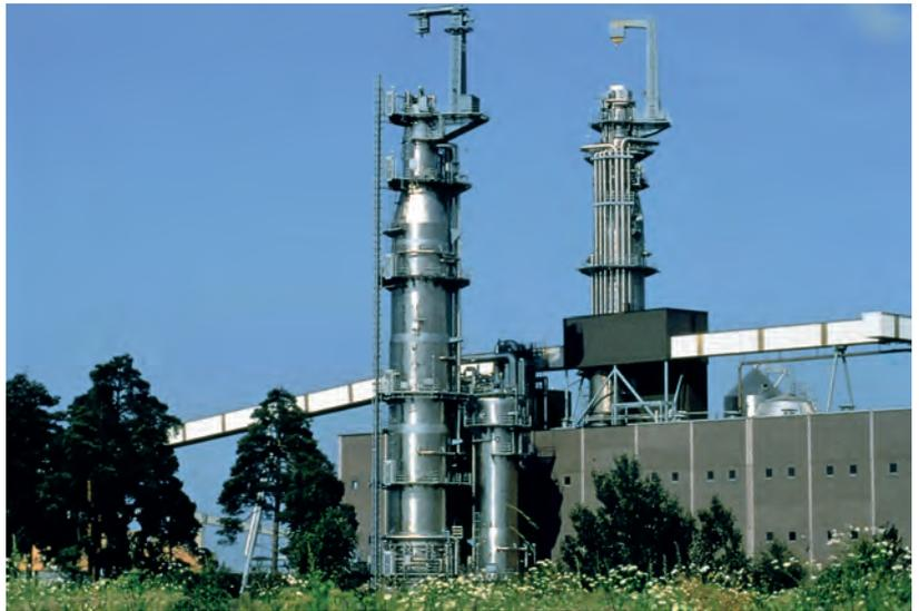
Lessiveur continu et tour d'imprégnation utilisés dans la fabrication de pâte kraft, acier EN 1.4462 (2205), Södra Cell Mönsterås, Suède (Source : Kværner Pulping)
