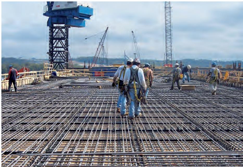
**Installation d'armatures en acier inoxydable duplex sur un tablier de pont de grande largeur (Source : Hardesty & Hanover, LLP)**
